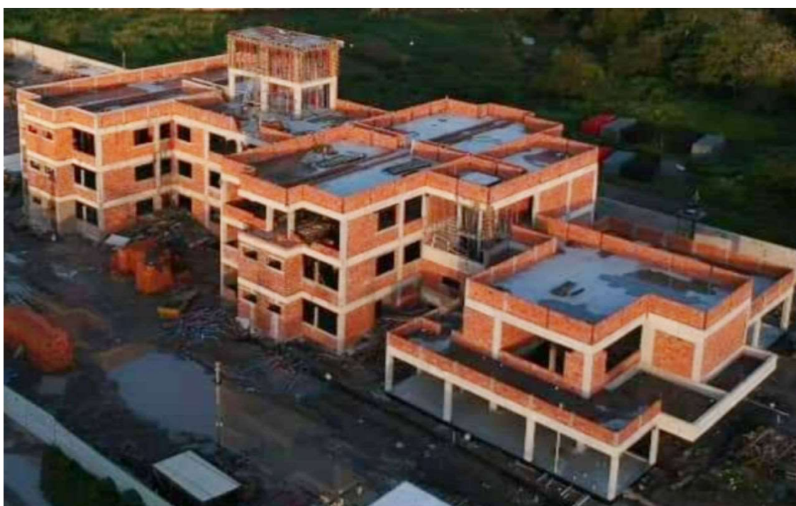
Figura 1: Execução de alvenaria convencional em concreto armado
