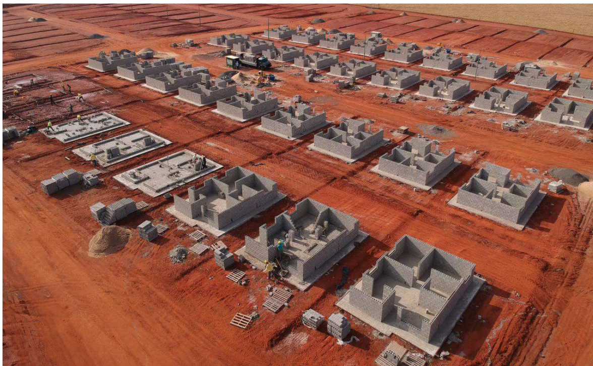
Figura 2: Execução de alvenaria estrutural
