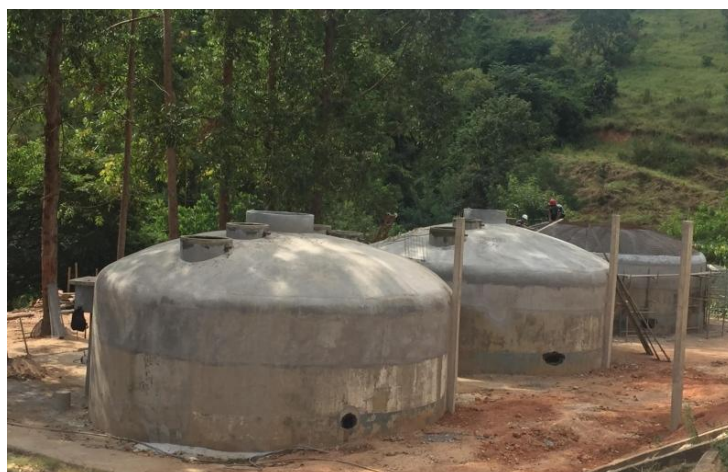
Figura 10 – Reatores após a cura do ferrocimento
