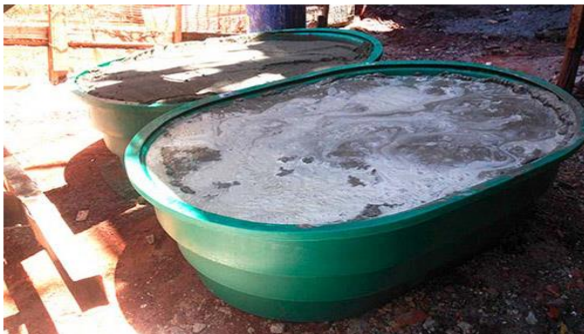
FIGURA 3 - Argamassa estabilizada com película de água ao fim do expediente
