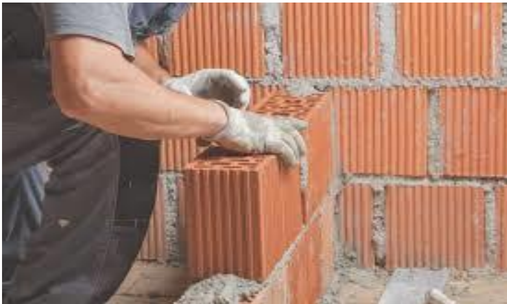
FIGURA 1: Levante de alvenaria
