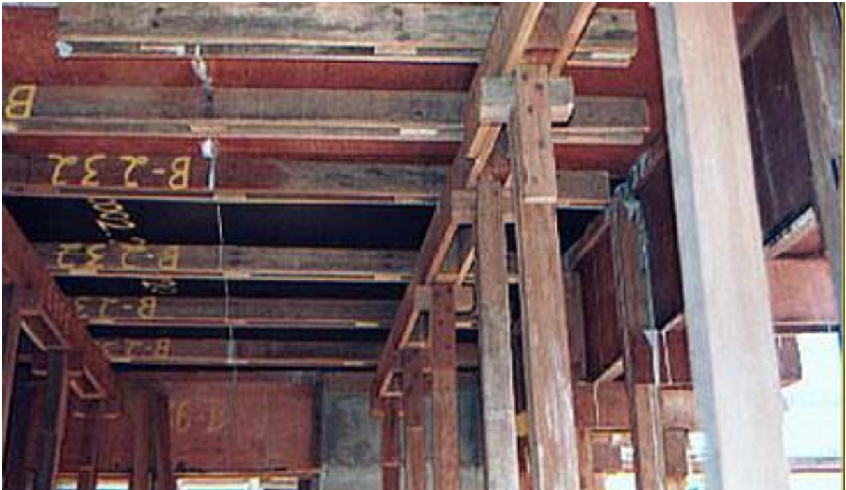
Figura 3: Cimbramento com madeira serrada
