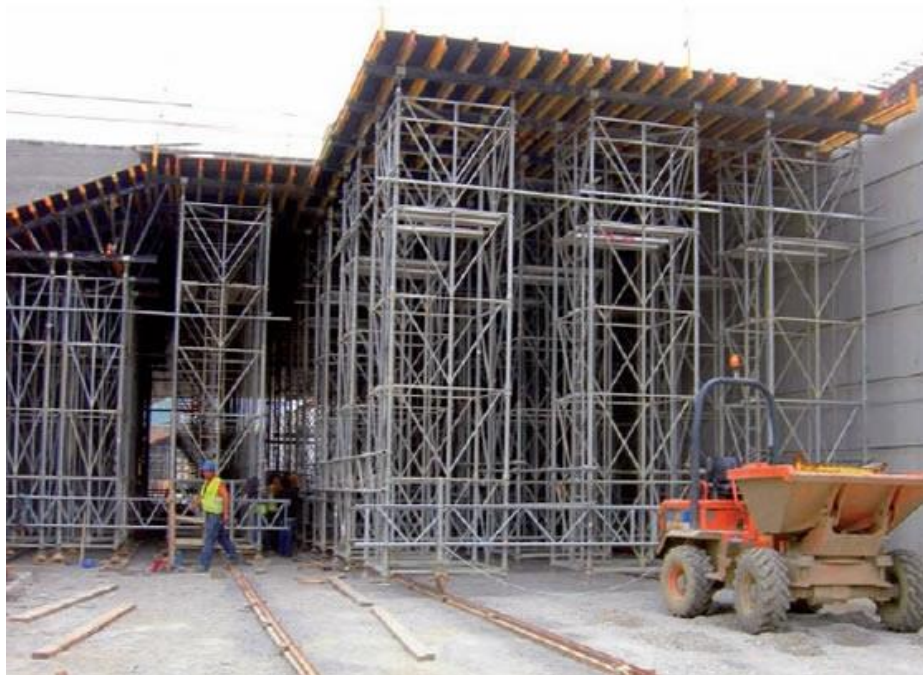
Figura 5: Torre metálica utilizada para pé direito alto/ duplo
