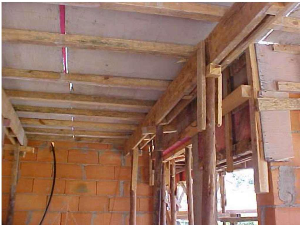
Figura 1: Escoramento em madeira bruta
