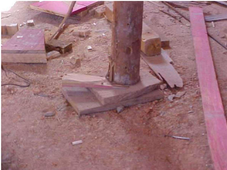
Figura 2: Cunha em madeira para regulagem do escoramento
