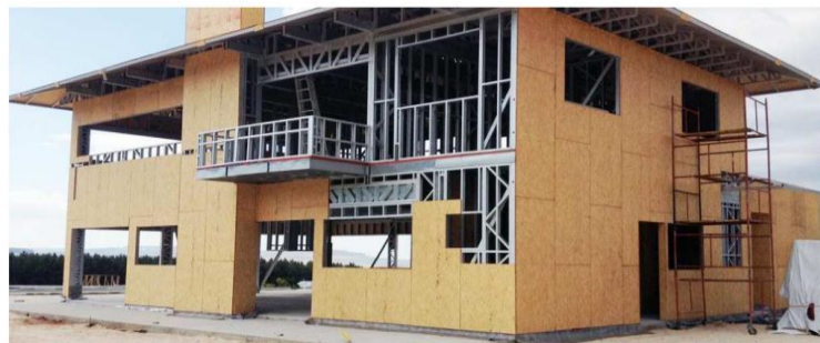
Figura 6- Fechamento Externo com Placas de OSB
