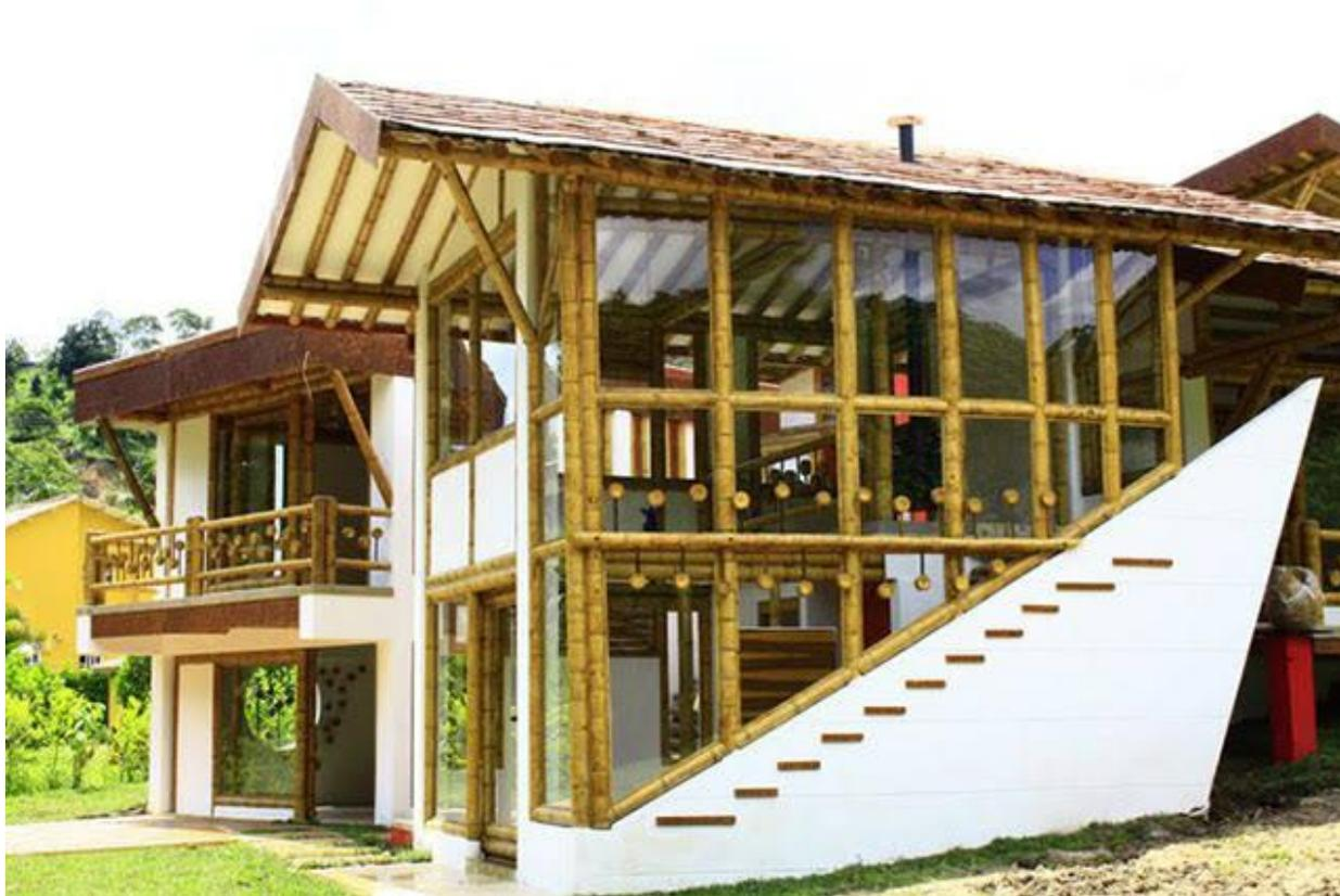
Figura 3: Utilização do bambu com Pilar e viga. Fonte: dryplan.com.br
