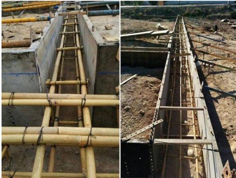
Figura 4: Utilização do bambu armação para vigas. Fonte: dryplan.com.br
