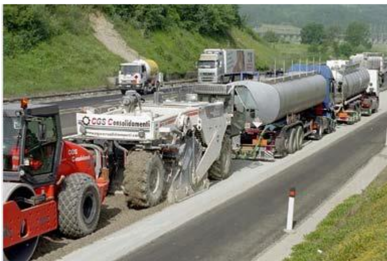
Figura 3 – “Comboio” de reciclagem
