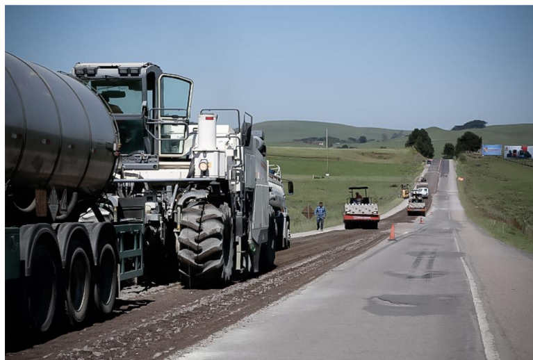
Figura 1 – Obra de reciclagem
