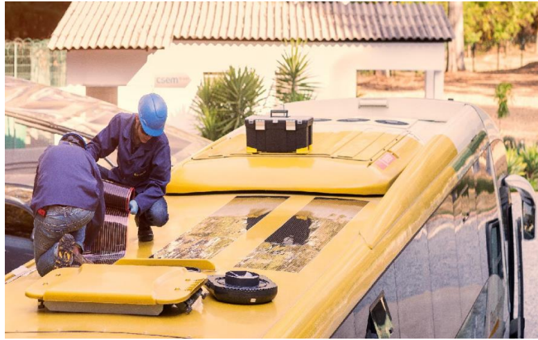
Figura 9. Instalação de OPV em veículos de transporte coletivo
