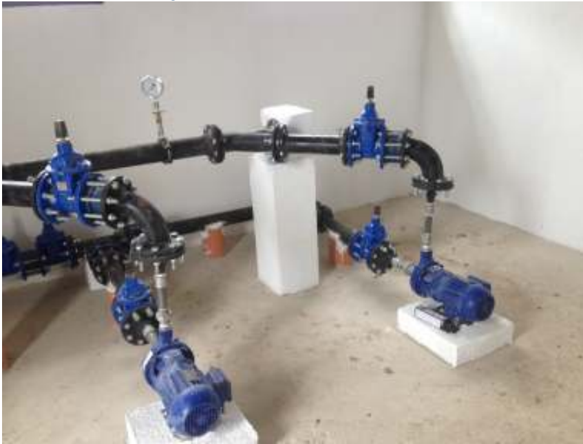
Figura 1 – Barrilete de Bomba Horizontal
