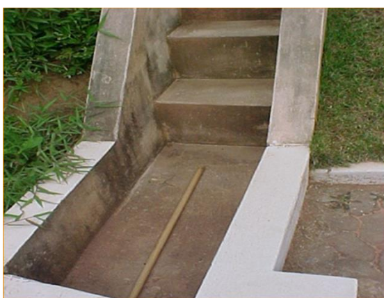
FIGURA 19 – Caixa de dissipação
