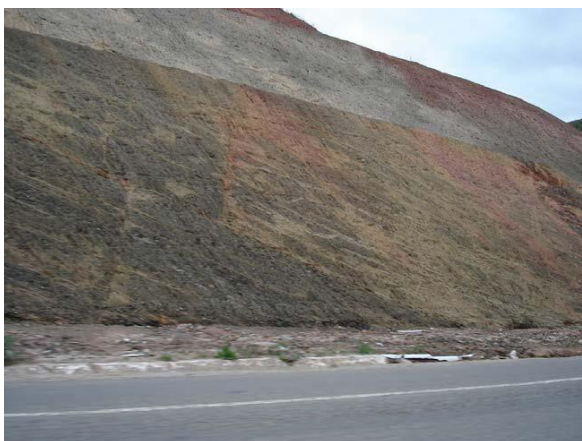
FIGURA 3 – Talude artificial em corte
