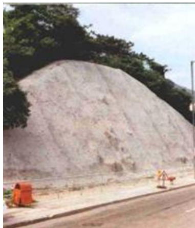
FIGURA 16 – Proteção com Impermeabilização
