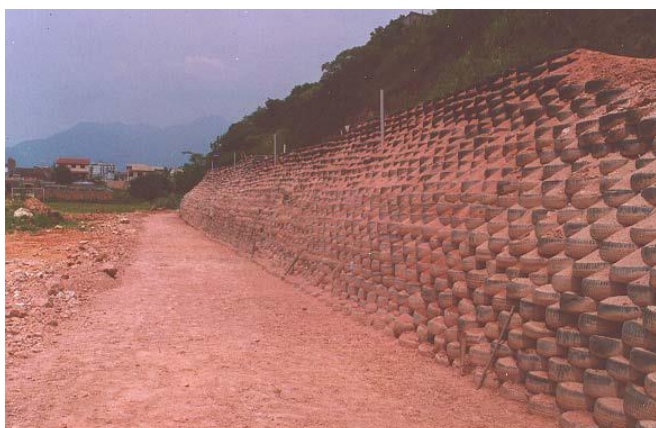
FIGURA 23 – Final da construção do muro
