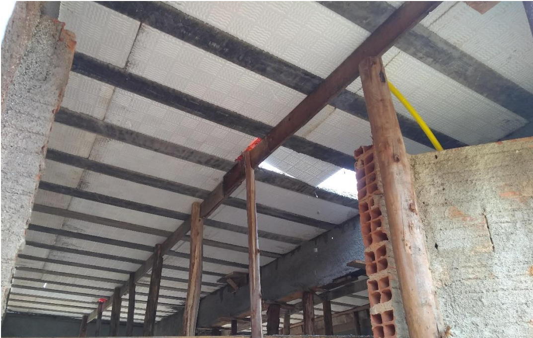
Figura 2: Laje treliçada unidirecional
