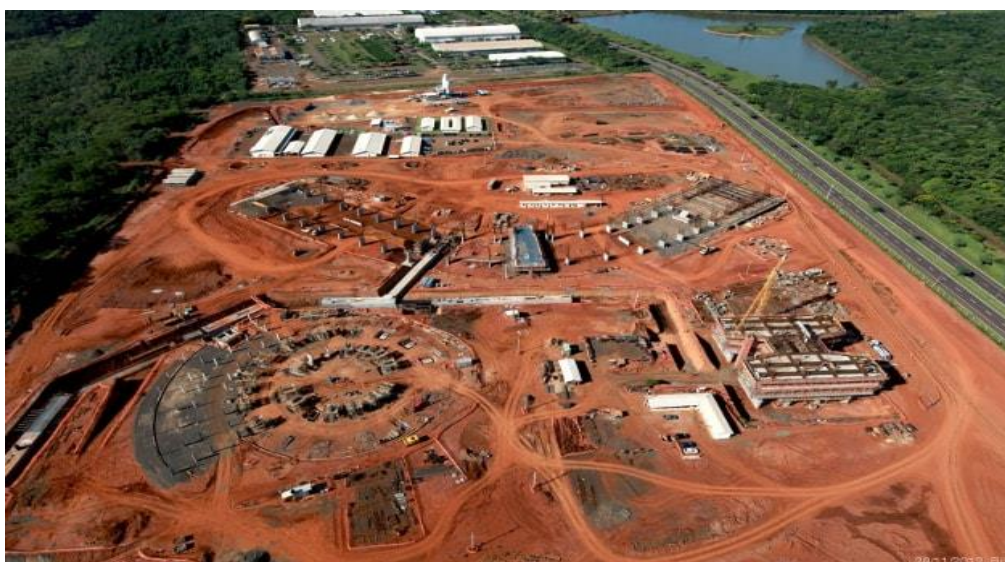
Figura 2 – Canteiro de obras amplo
