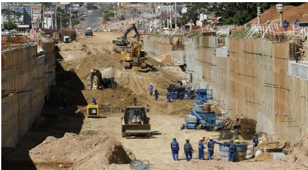
Figura 3 – Canteiro de obras linear
