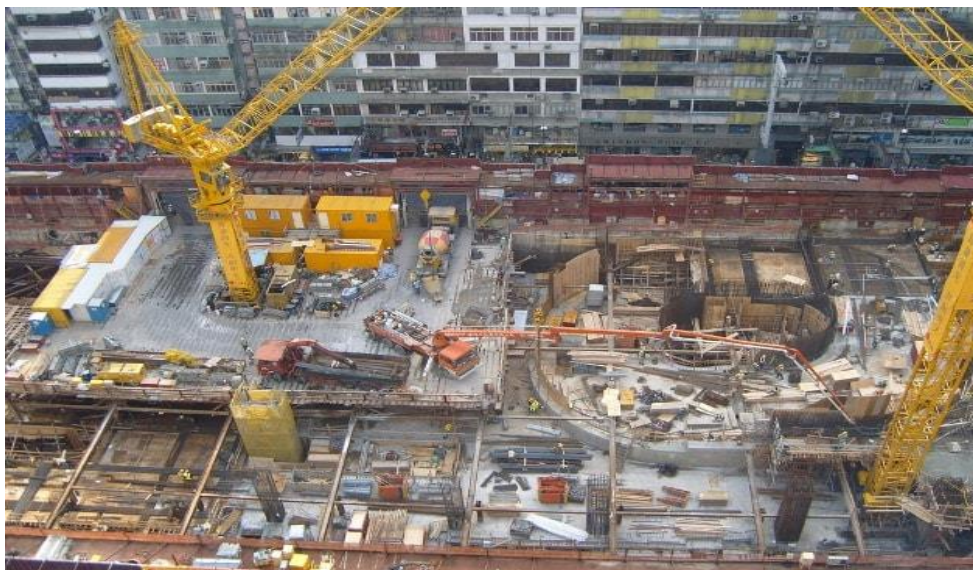
Figura 1 – Canteiro de obras restrito
