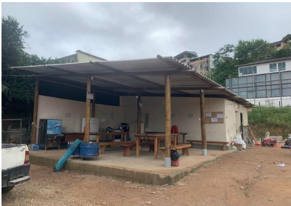
Figura 6 – Instalação provisória: refeitório, cozinha, almoxarifado e armazenamento de material.
