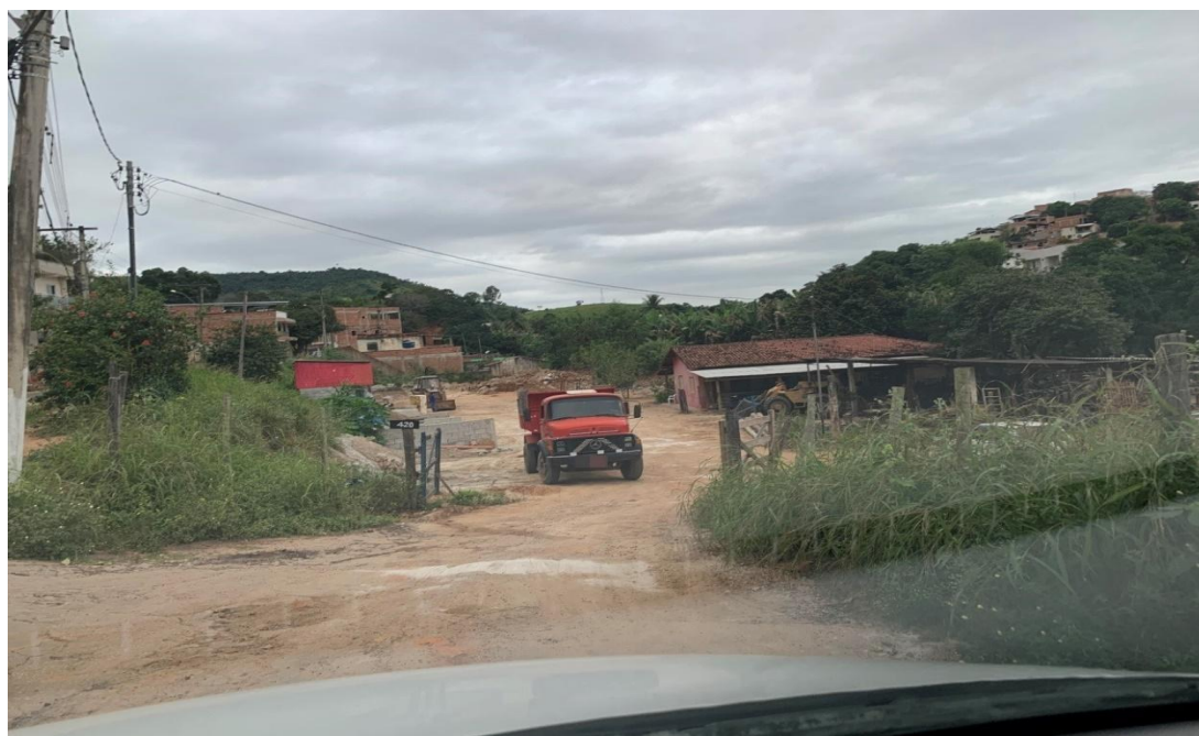
Figura 5 – Vista frontal do canteiro de obras.
