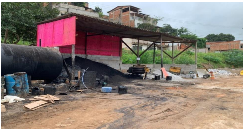
Figura 9 – Instalação provisória: local de fabricação de asfalto.
