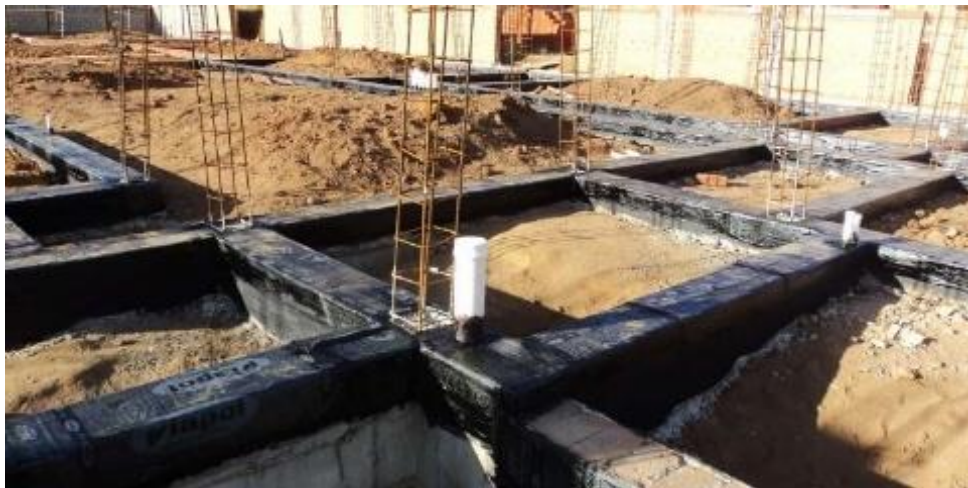
Figura 2. Concretagem de uma viga baldrame
