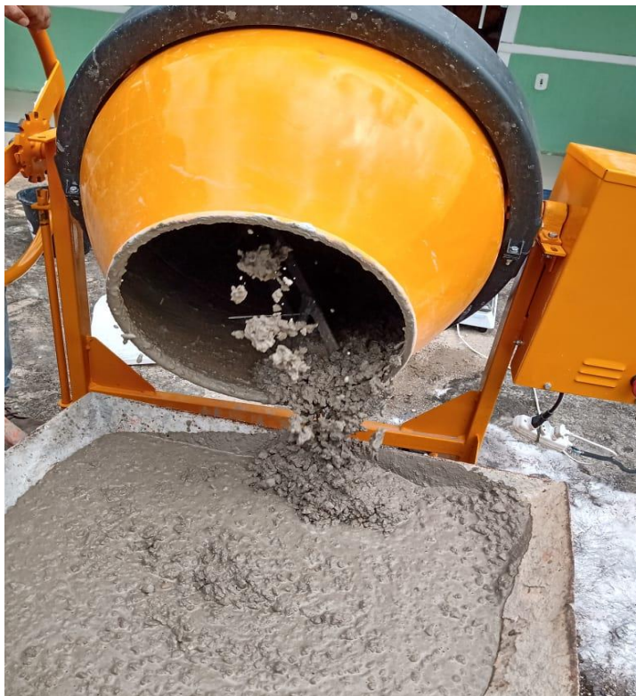
Figura 20: Coletando amostra do concreto
