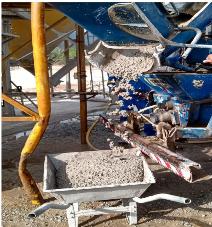
Figura 14: Coletando amostra do concreto
