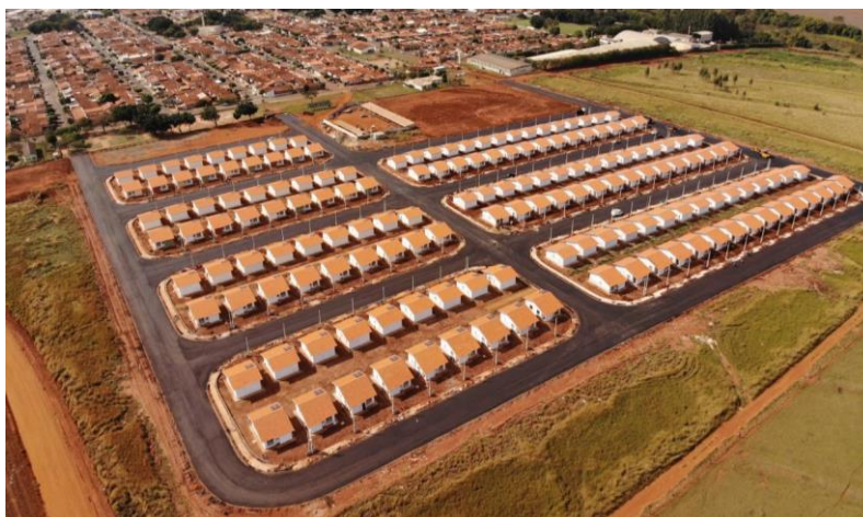
Figura 03: Empreendimento Macatuba (Vista Aérea)
