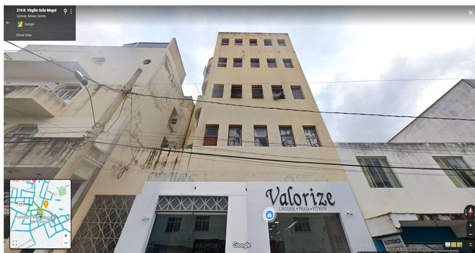
Figura 12: Fachada frontal da edificação
