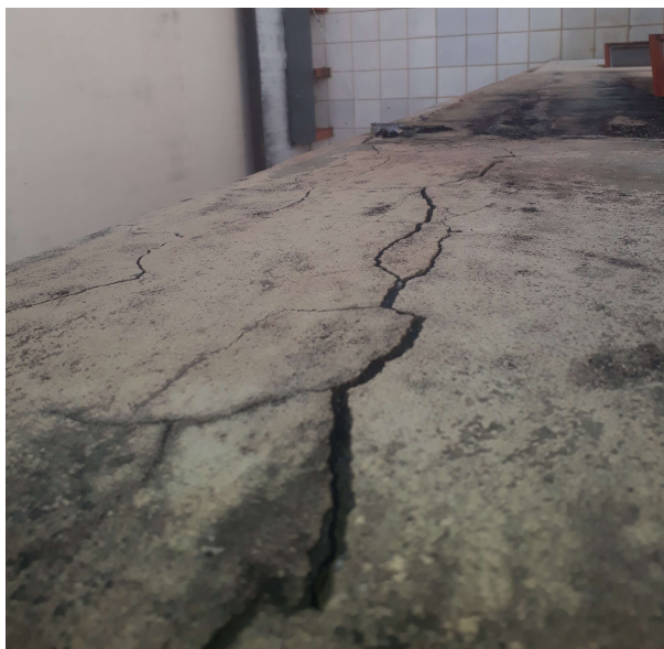
Figura 10: Fachada posterior vista de cima
