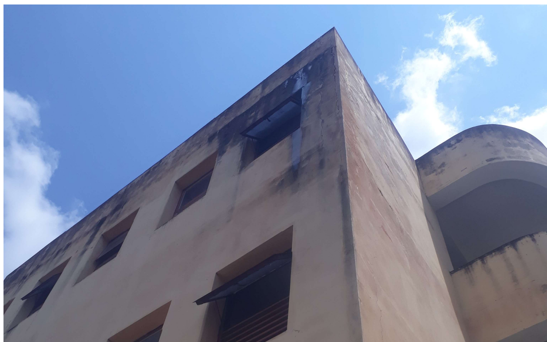
Figura 9: Fachada posterior da edificação
