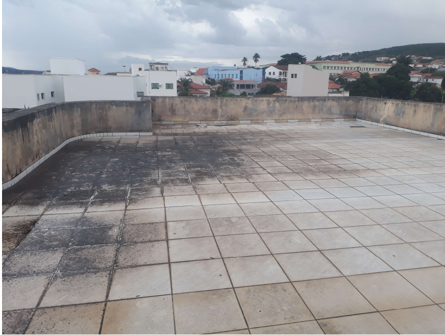
Figura 7: Terraço da edificação
