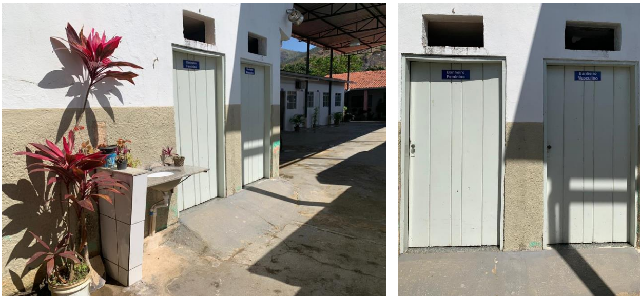
Figura 15 e 16 – Instalações Sanitárias, Local de funcionamento da APAE.
