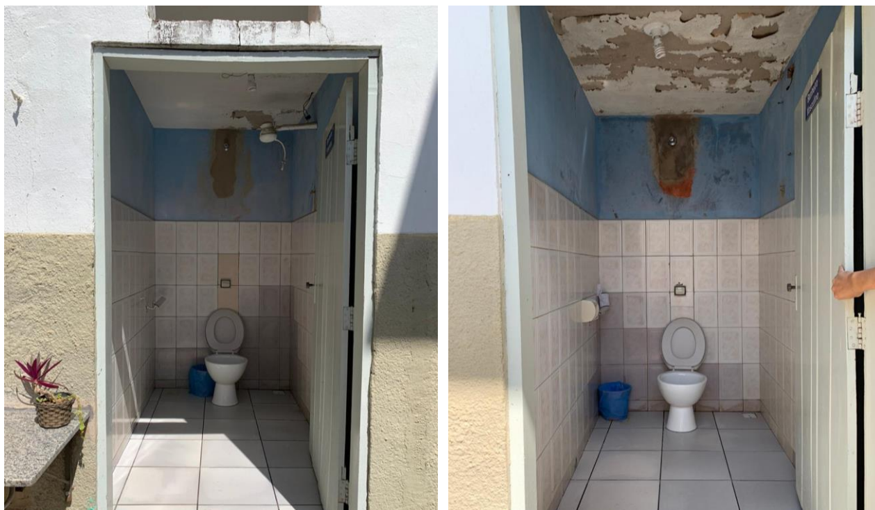
Figura 17 e 18 – Instalações Sanitárias, Local de funcionamento da APAE.
