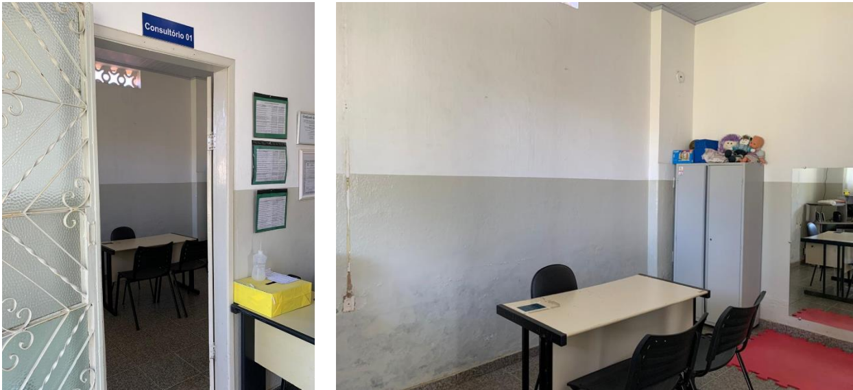
Figura 07 e 08 – Consultório 01, Local de funcionamento da APAE.
