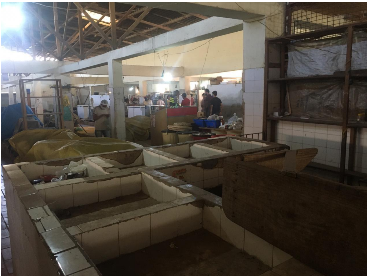
Figura 14- Área interna Mercado Shozo Inão.
