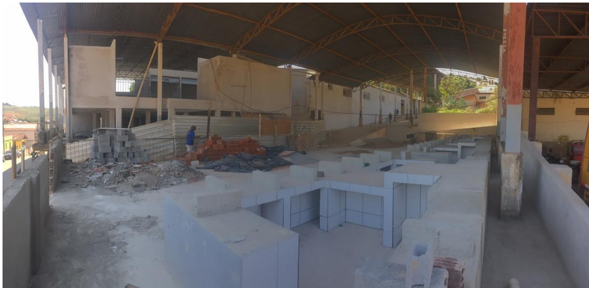
Figura 13- Reforma no anexo do Mercado Shozo Inao.
