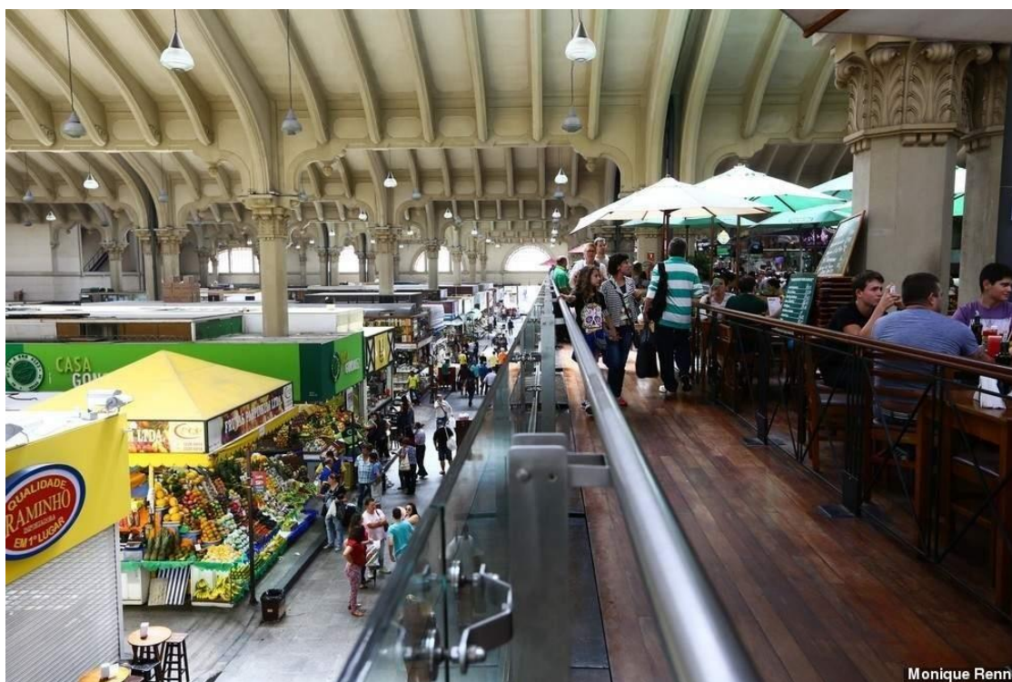
Figura 18- Vista do mezanino, Mercado Municipal Paulistano.
