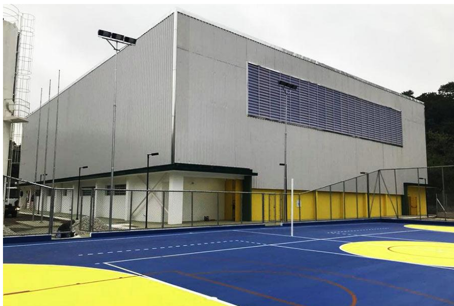
FIGURA 37 – VISTA EXTERNA DO CIE TABOÃO DA SERRA - SP
