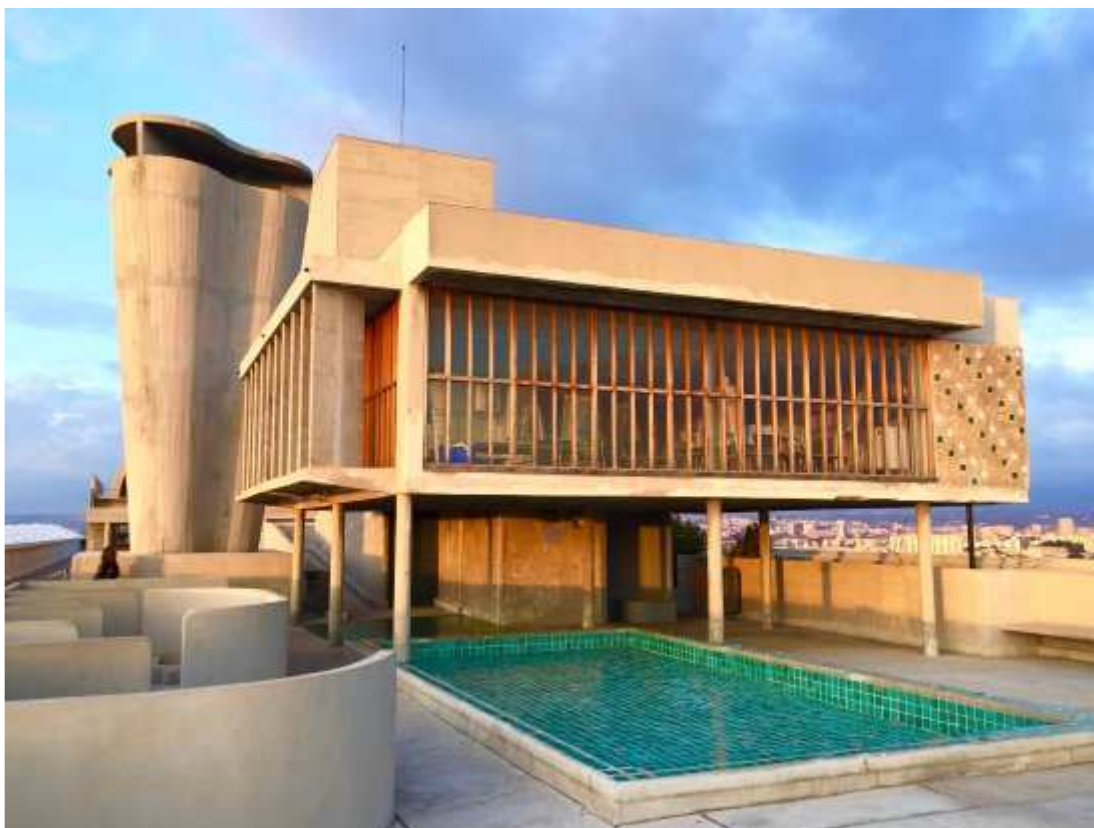
Figura 26 - Cobertura da Unidade Habitacional de Marselha
