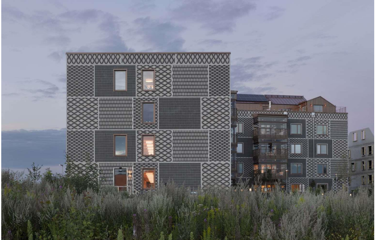
Figura 9 – Fachada Centro de Atenção aos Idosos
