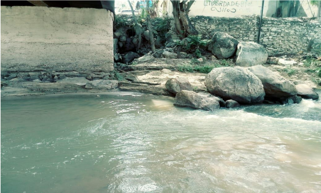
Figura 05 – Esgoto Lançado no Córrego São João.
