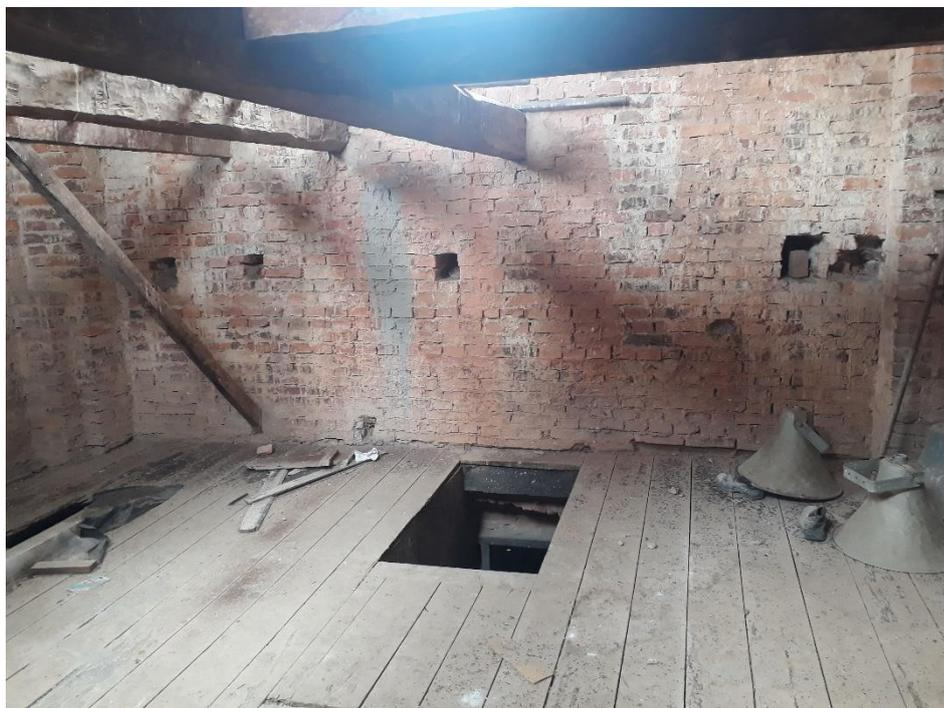
**Imagem 12** – Piso de madeira danificados e com necessidade de troca
