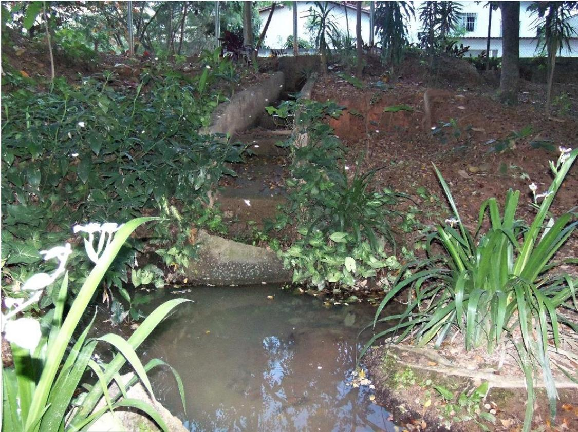
Figura 5. Queda de drenagem pluvial sobre nascente.
