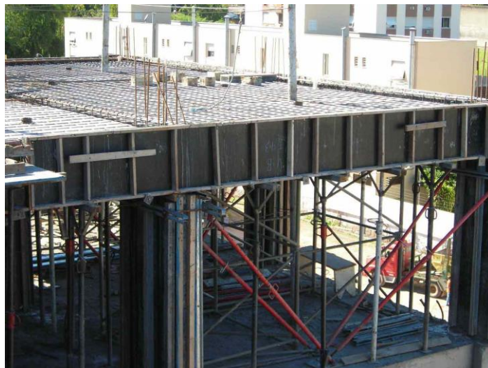
FIGURA 9: ESTRUTURA EM CONCRETO ARMADO.
