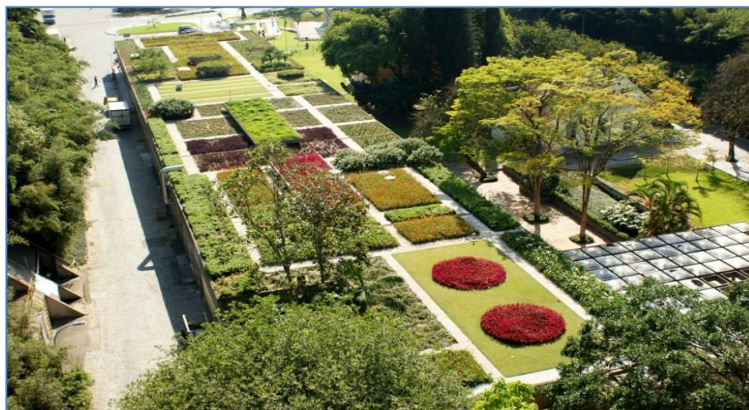
Figura 8 – Telhado Verde - Telhado Verde na sede da Cia. Hering, em Blumenau-SC
