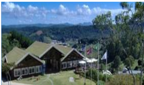
Figura 2 – Telhado Verde - Rancho em Pedra Azul-ES
