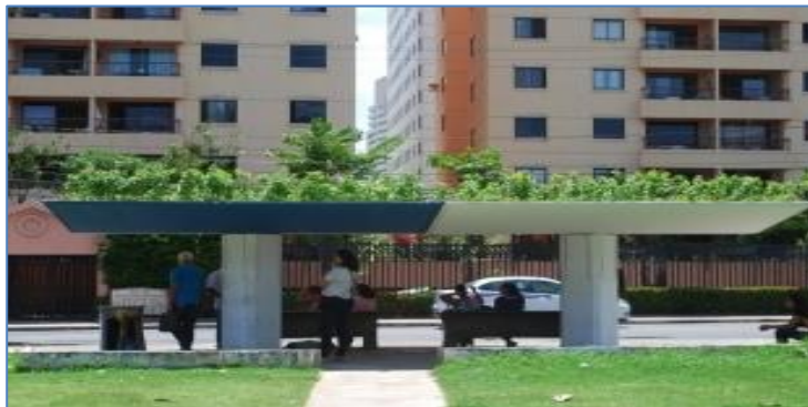
Figura 9 – Telhado Verde – Ponto de ônibus no bairro Stiep, na Capital de Salvador-BA
