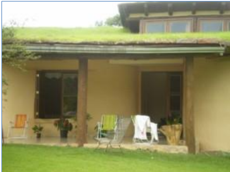
Figura 6 – Telhado Verde de Construção Extensiva em Sarandi-RS
