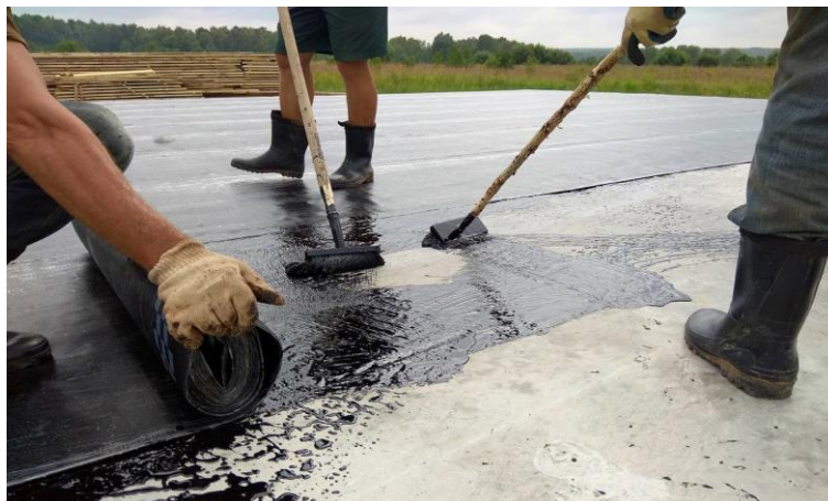
FIGURA 9 – Aplicação Membrana asfáltica a frio
