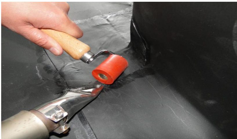
FIGURA 15 – Processo de solda com equipamento manual
