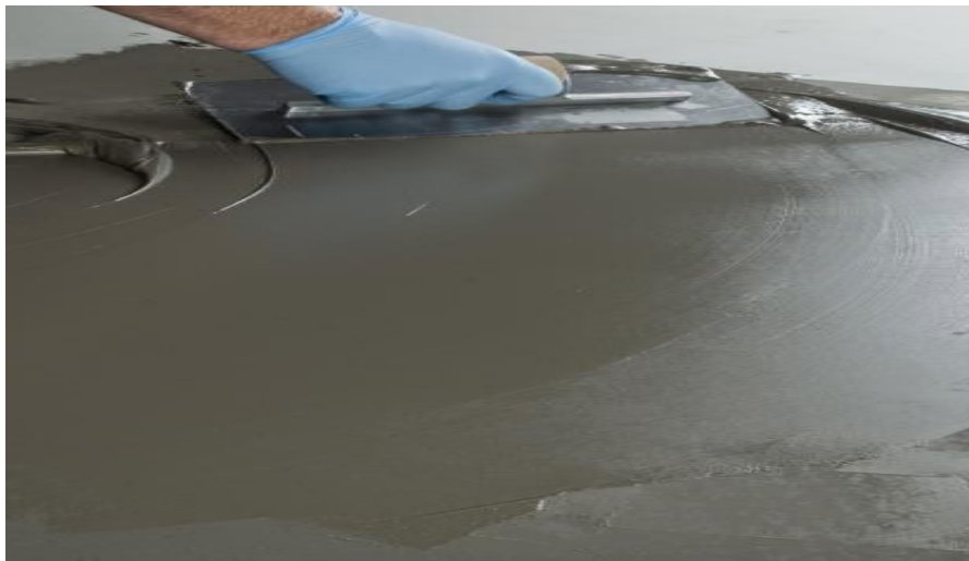
FIGURA 7 – Aplicação argamassa polimérica como revestimento
