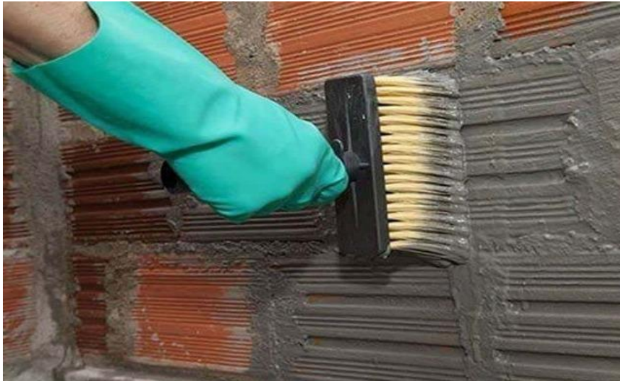
FIGURA 6 – Aplicação argamassa polimerica como pintura
