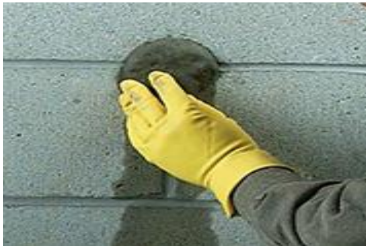
FIGURA 5 – Aplicação Argamassa pega ultra rápida
