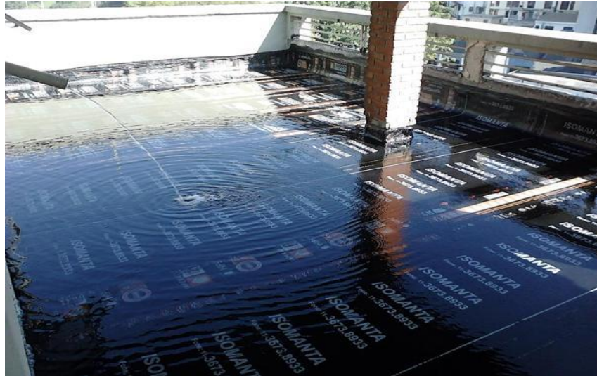
FIGURA 12 – Manta asfáltica e teste de estanqueidade
