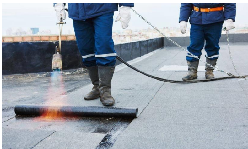
FIGURA 10 - Aplicação Membrana asfáltica a quente
