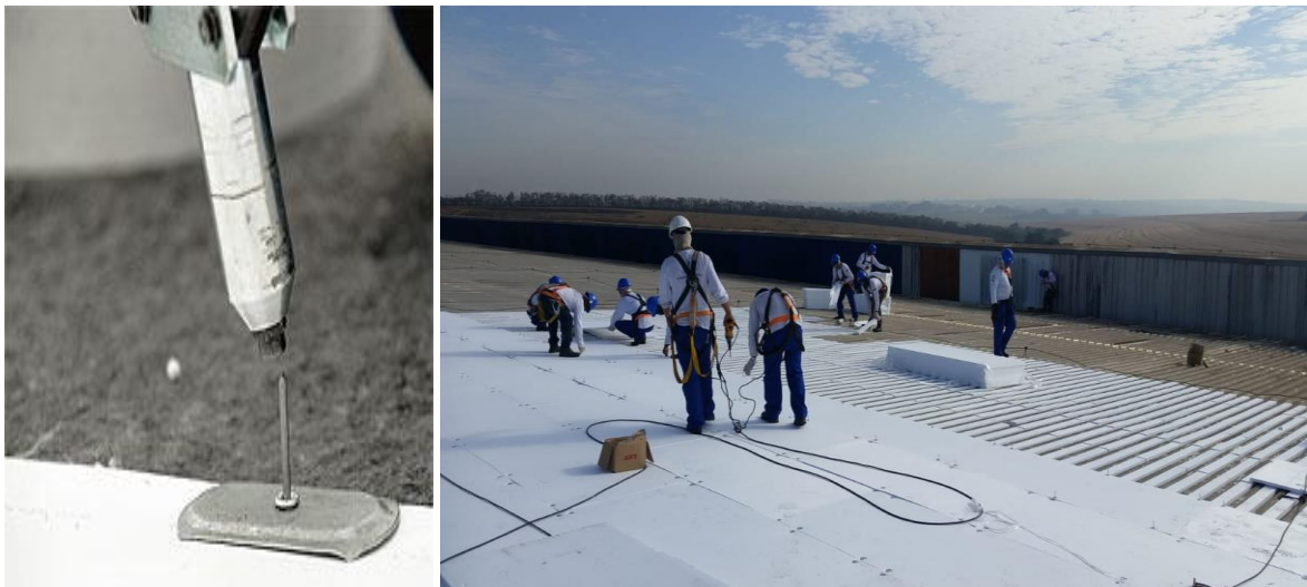
FIGURA 16 – Instalação manta PVC com parafusos de fixação
