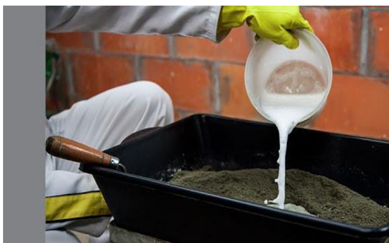
FIGURA 2 – Preparação de argamassa com aditivo hidrófugo.
