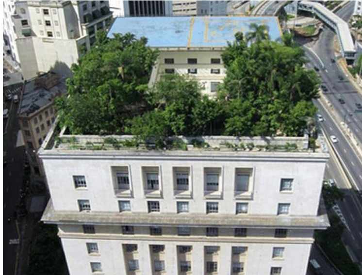
Figura 4 – Sistema Intensivo – Edifício Conde Matarazzo, sede da Prefeitura de São Paulo
