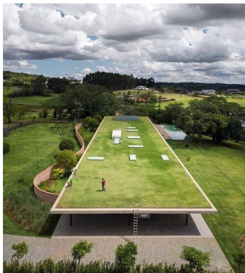
Figura 3 – Sistema de Telhado Extensivo
