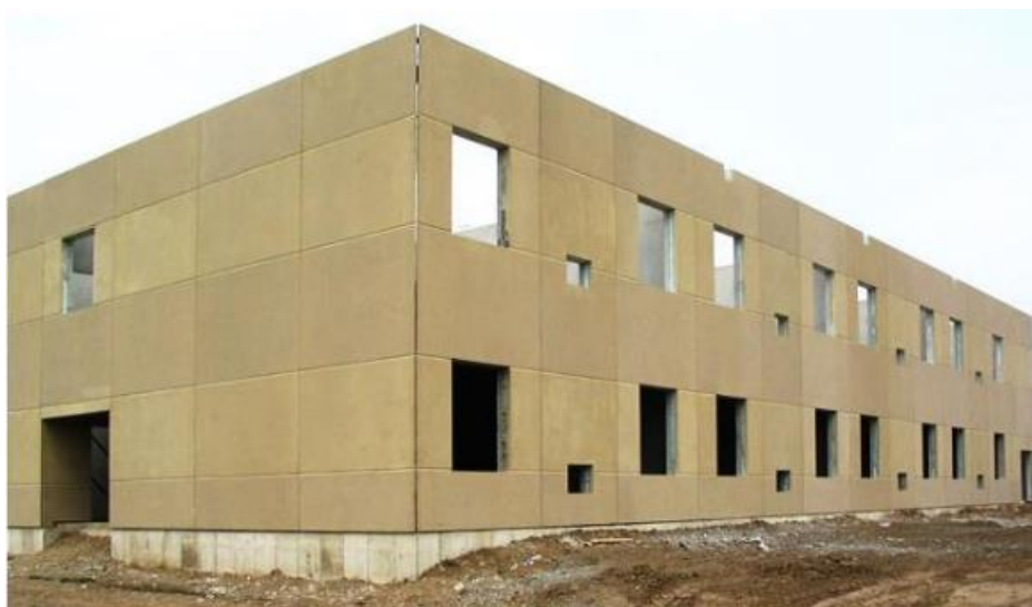
Figura 2 – Escola em Brantford em painéis de concreto, Canadá.
