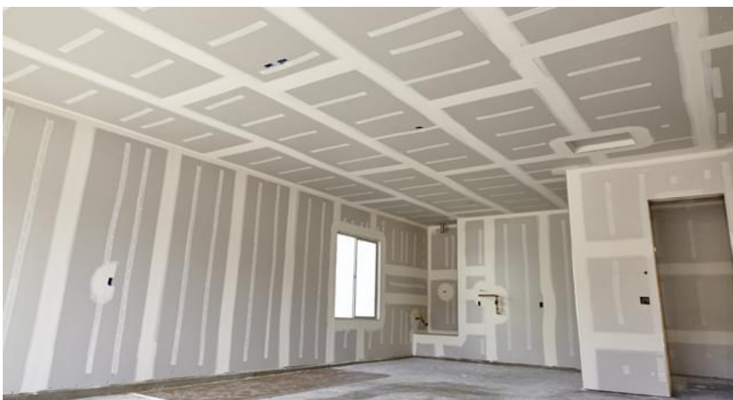
Figura 4 – Construção em drywall.
