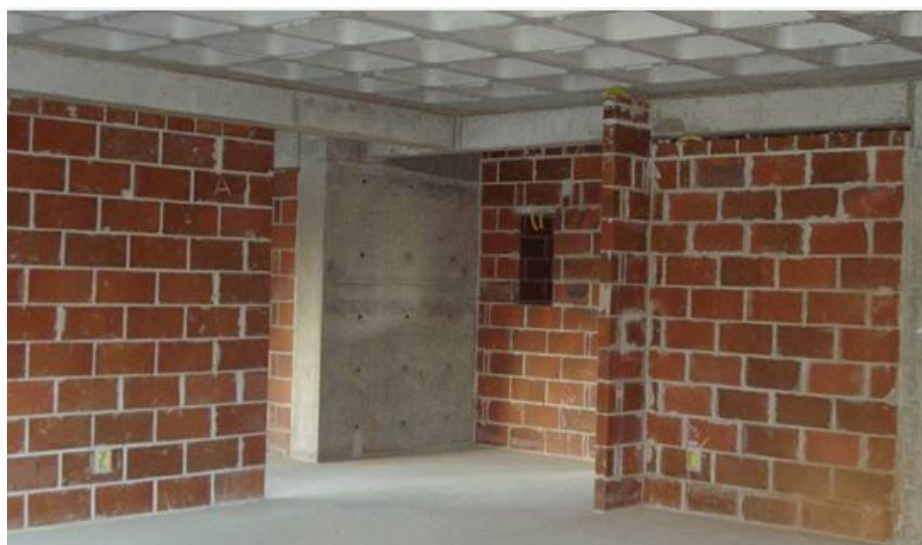
Figura 1 – Vedação de edifício em alvenaria.
