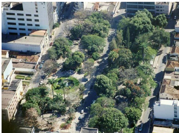
Figura 20 – Vista parcial superior
