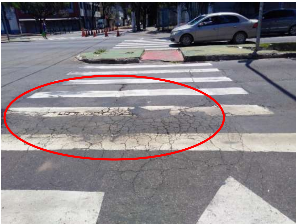
Figura 01: Trincas interligadas do tipo “Couro de Jacaré” no pavimento
