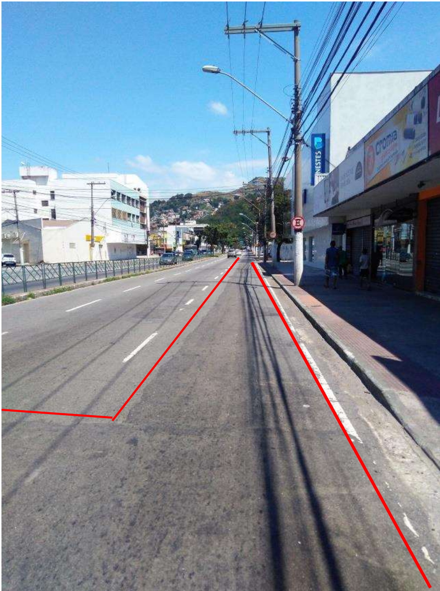
Figura 03: Remendo em vala de esgoto
