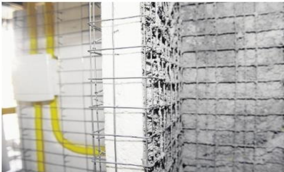
Figura 5 – Construção monolítica em painéis de EPS.
