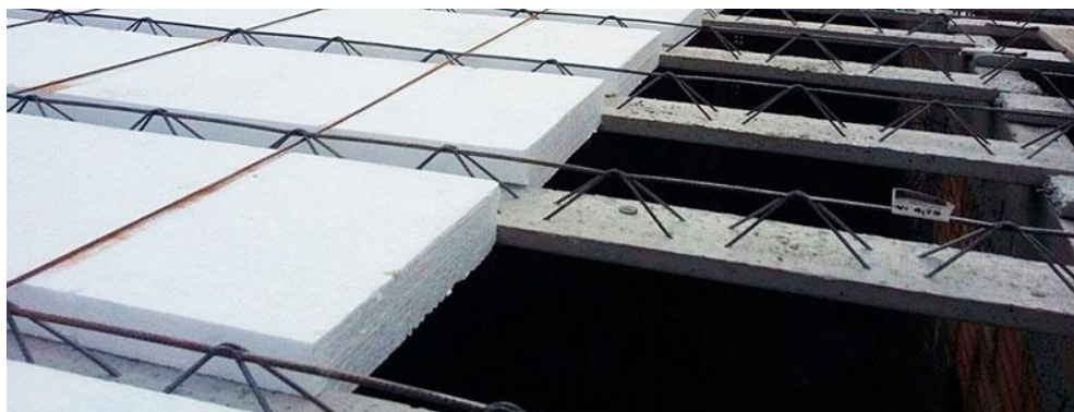
Figura 3 – Laje treliçada unidirecional com uso de placas de isopor.
