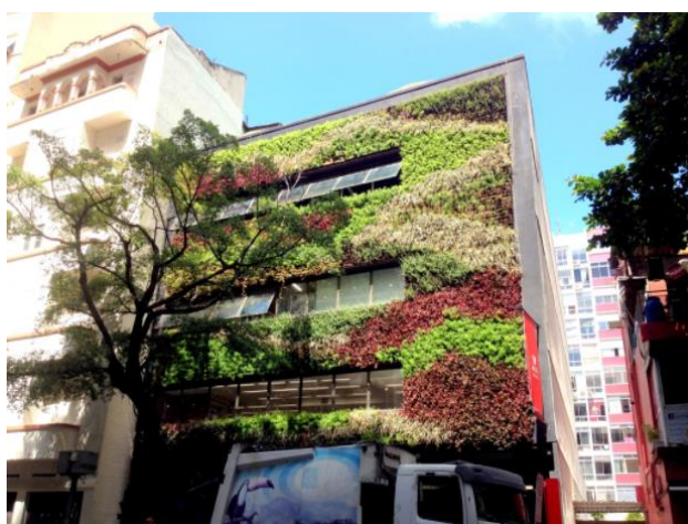
Figura 13 - Edifício Comercial/ Residencial com sistema Canguru
