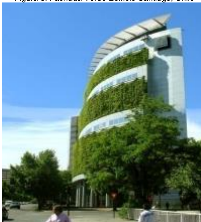
Figura 8: Fachada Verde Edifício Santiago, Chile
