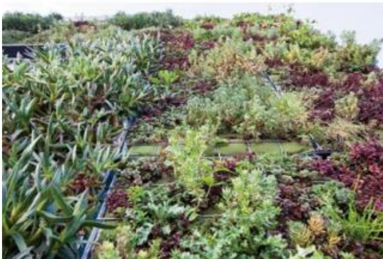
Figura 29 - Vegetação instalada na chapa de aço
