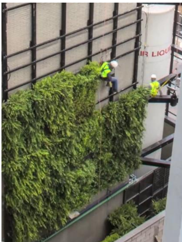
Figura 25 - Montagem do Jardim vertical
