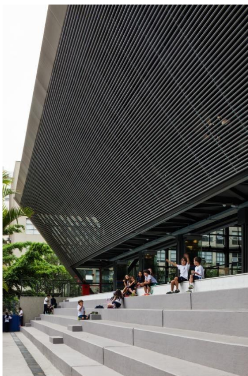
Figura 11 - Ginásio de esporte do colégio São Luís - Fachada
