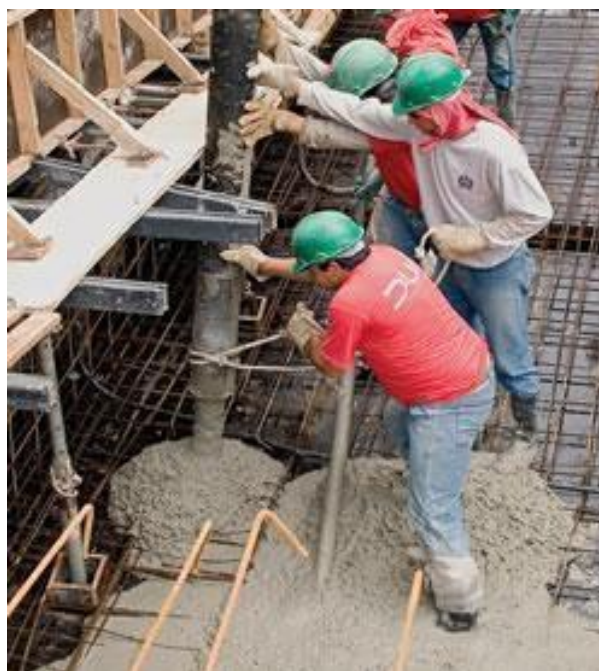
Figura 5: Origem do problema:Execução
