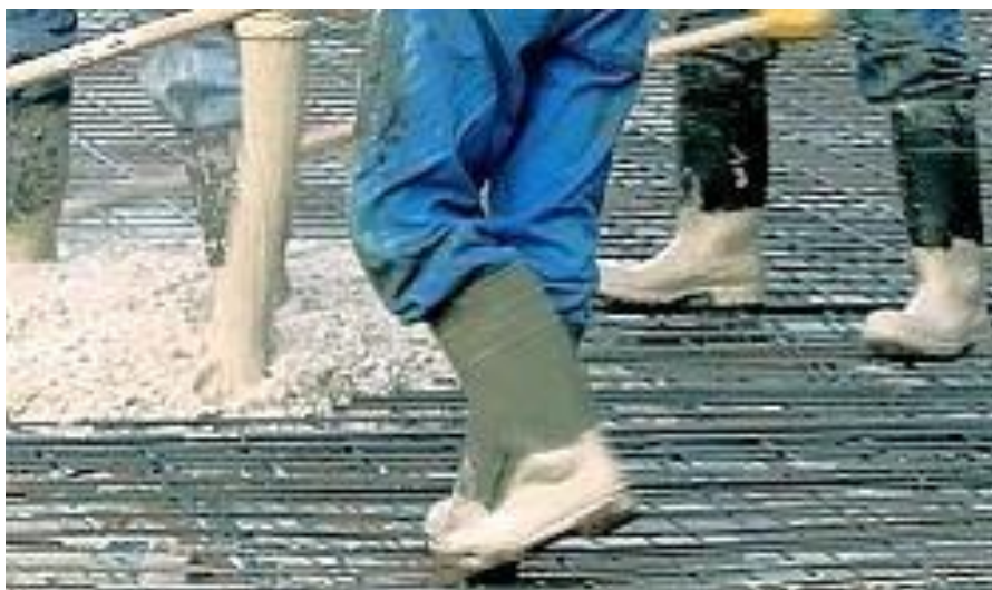
Figura 1 - Execução de concretagem na obra. Fonte: http://www.portaldoconcreto.com.br
