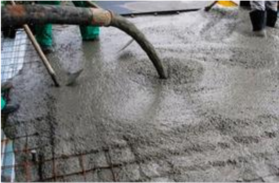
Figura 8 – Lançamento de concreto Fonte:
