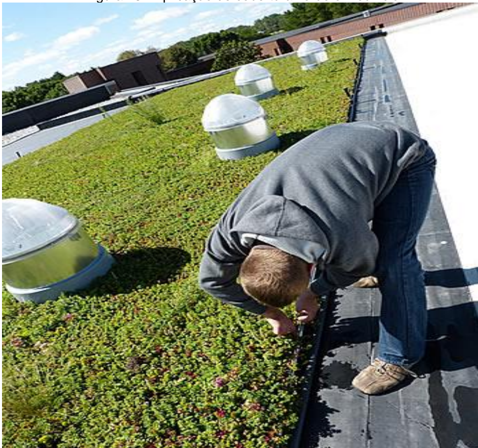
Figura 25 - Aplicação de cobertura verde em edifício
