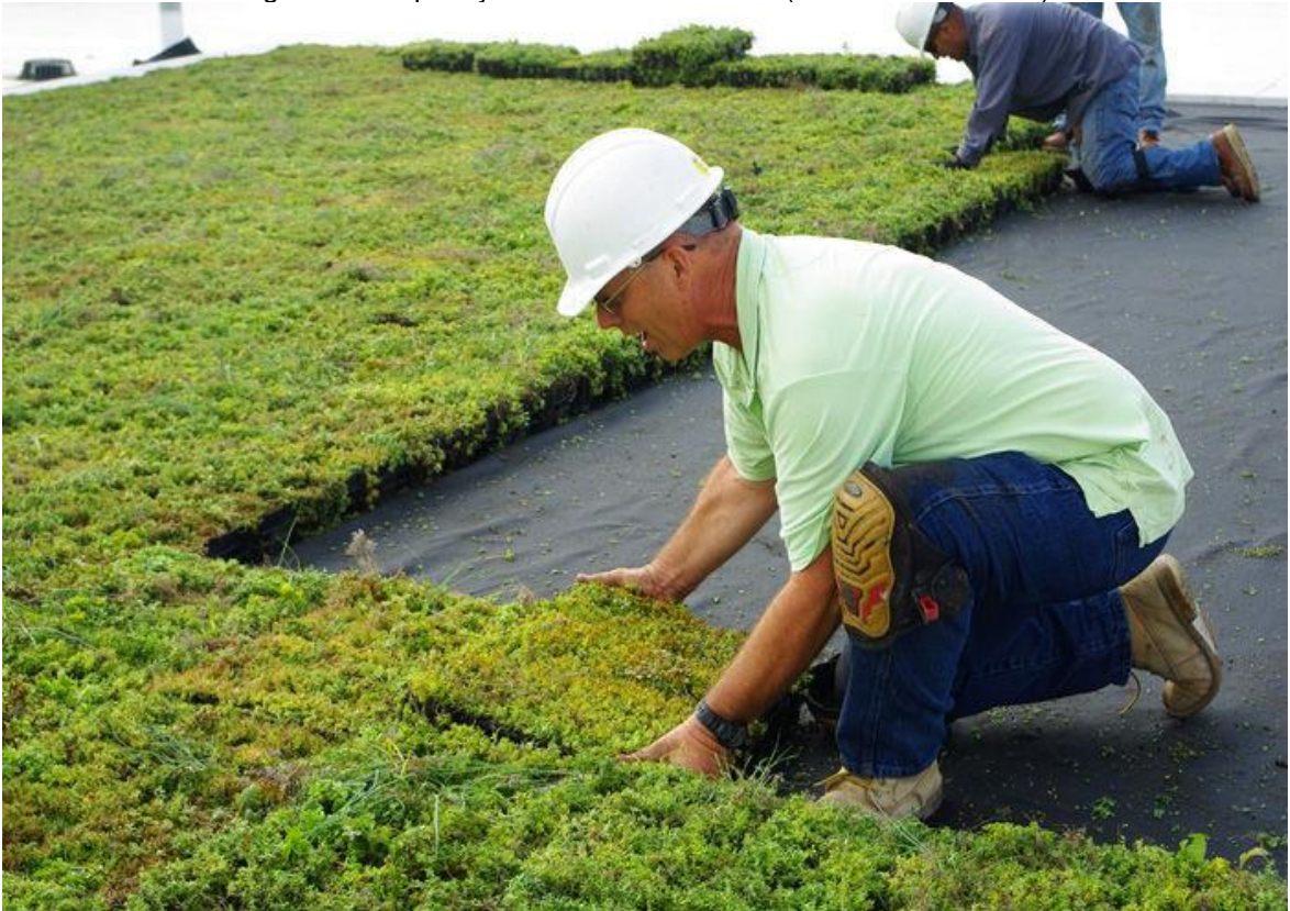
Figura 24 – Aplicação de cobertura verde (cobertura intensiva)
