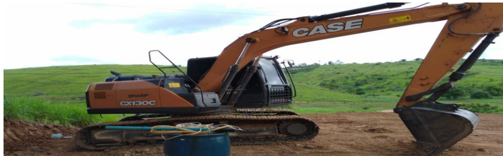
Figura 3: Máquina de Terraplanagem
