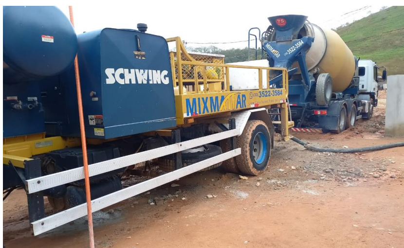
Figura 7: Transporte e bombeamento de concreto
