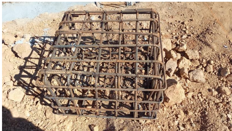
Figura 6: Armadura de bloco de fundação
